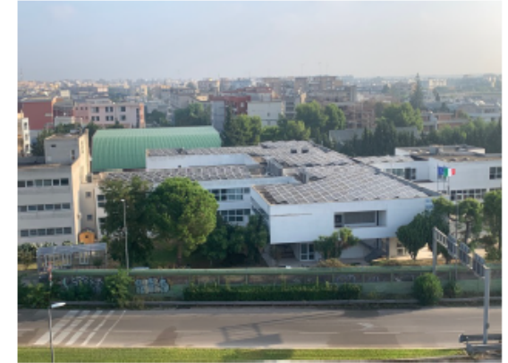
Particolare impianto fotovoltaico
